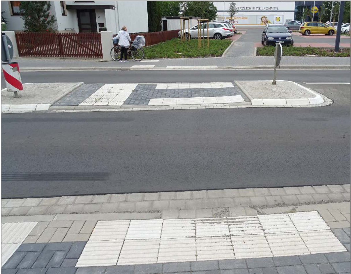
Abb. 6.2: Querungsstelle mit taktilen Elementen und Nullabsenkung (Beispiel Querungsstelle Nordstraße, Höhe LIDL)
