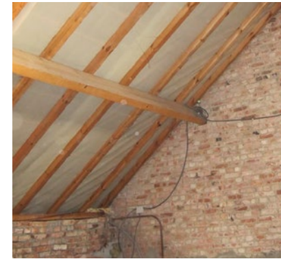
Abbildung 35 – 37 Vergrößerung des Sparrenzwischenraums durch seitlich angebrachte Sparrenexpander aus Holz
