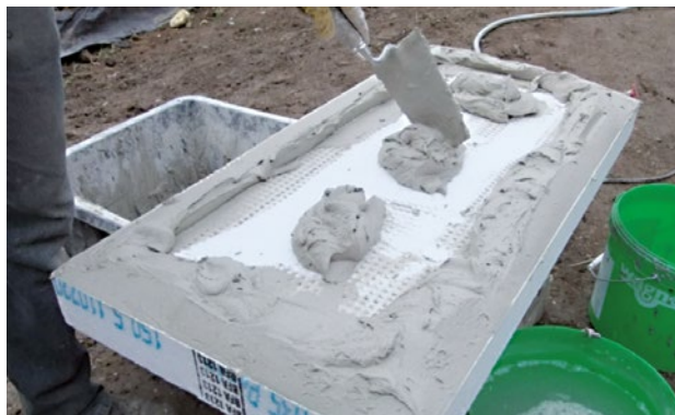
Abbildung 67 Verklebung einer Sockeldämmplatte im Wulst-Punkt-Verfahren
