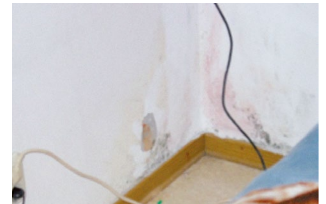
Abbildung 11 Erhöhung der Oberflächentemperatur im kritischen Bereich durch diffusionsoffene Innendämmung
