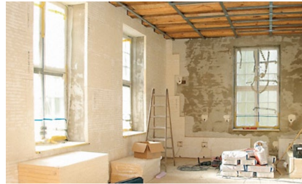
Abbildung 77/78 Vollflächiges Verkleben einer kapillaraktiven Innendämmung
