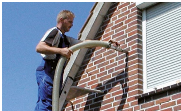
Abbildung 75 Einbringen einer Einblasdämmung (Bestand)
