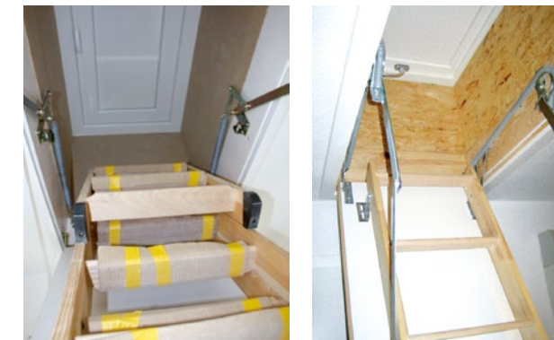
Abbildung 57/58 Neueingebaute Bodentreppen mit zusätzlich gedämmter Bodenklappe
