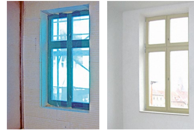
Abbildung 81/82 Einsatz eines Innenwand-Dämmsystems unter Einbeziehung der Fensterlaibungen
