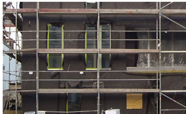
Abbildung 73 Anbringen der diffusionsoffenen Unterspannbahn
