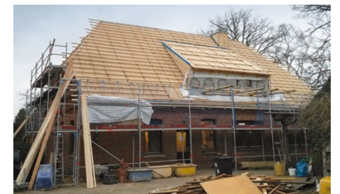
Abbildung 39 Aufsparrendämmung
