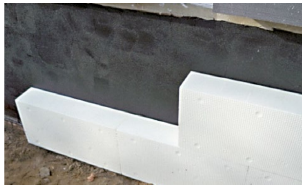
Abbildung 68 Angebrachte Perimeterdämmung im Sockelbereich
