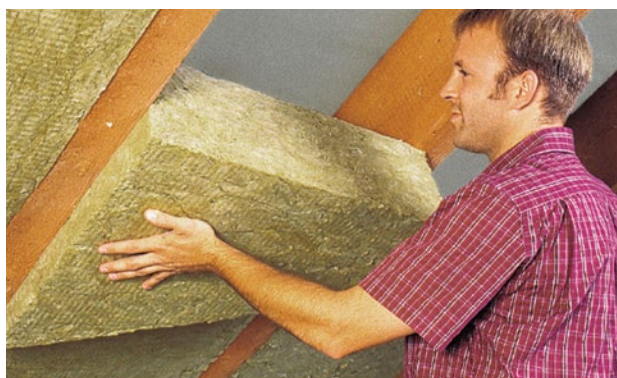
Abbildung 34 Zwischensparrendämmung aus Dämmkeilen
