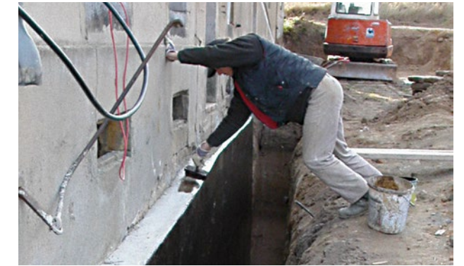
Abbildung 98 Anbringen des Voranstriches für die folgende Bitumendickbeschichtung
