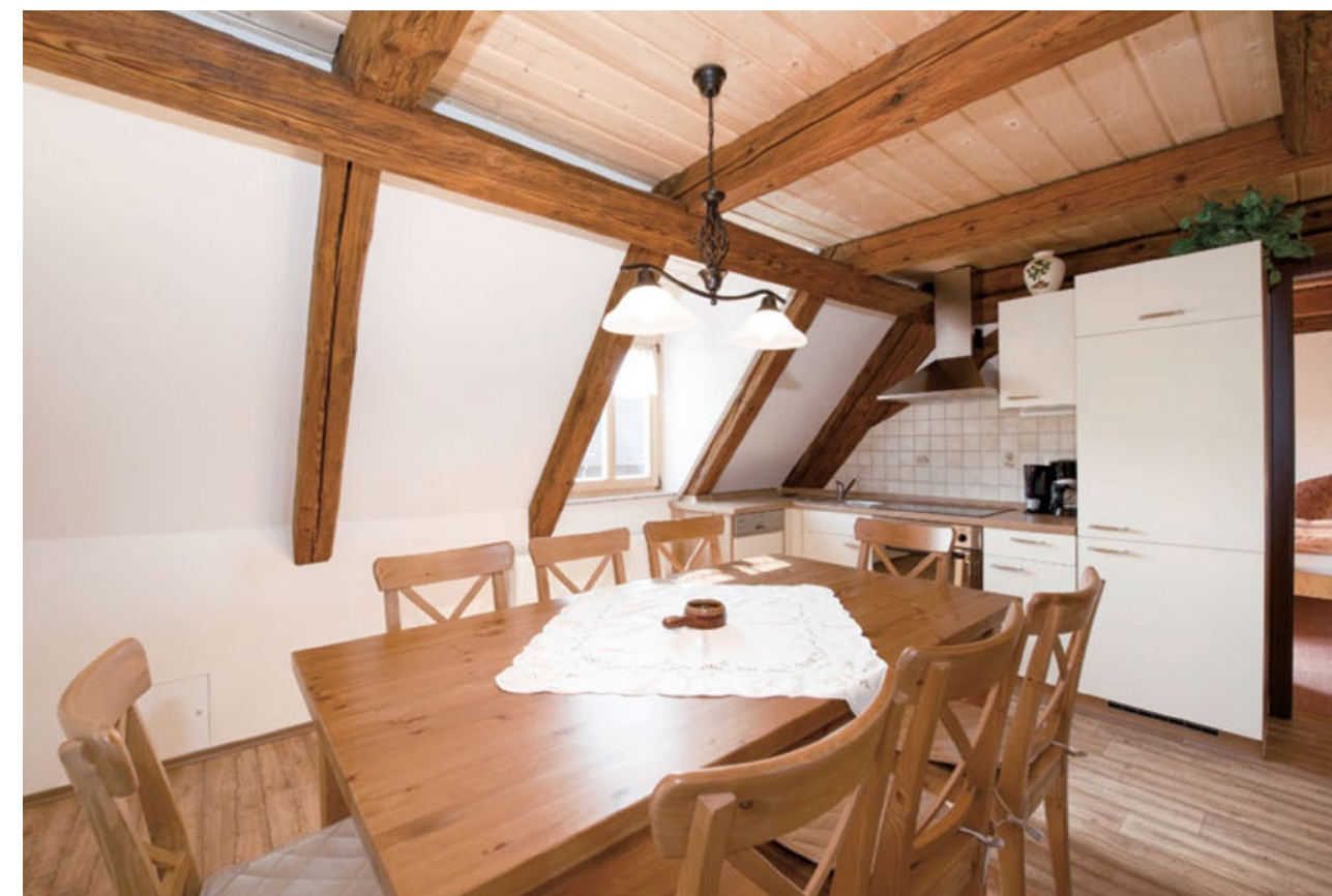
Abbildung 27 Ausgebautes Dachgeschoss unter Verwendung einer Aufsparrendämmung
