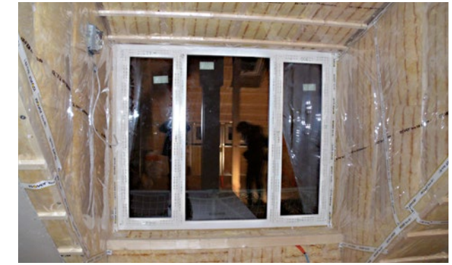
Abbildung 43 Dachgaube mit umlaufend angeschlossener Dampfbremse
