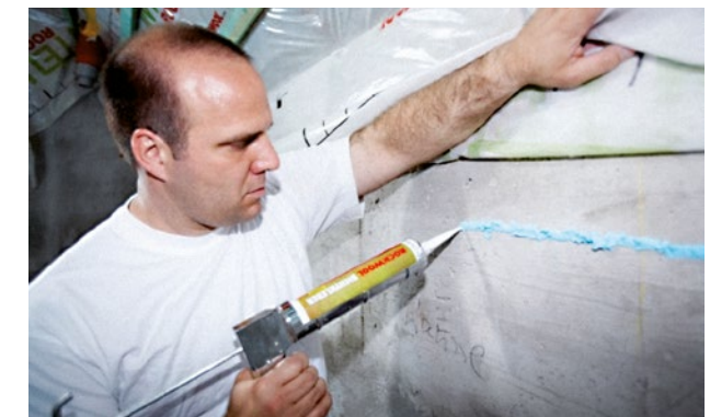
Abbildung 45 Herstellen eines dauerhaft luftdichten Anschlusses der Dampfbremse an flankierende Bauteile mittels eines speziellen Dichtklebers
