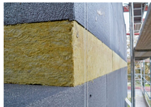
Abbildung 22 Brandriegel aus Mineralwolle
