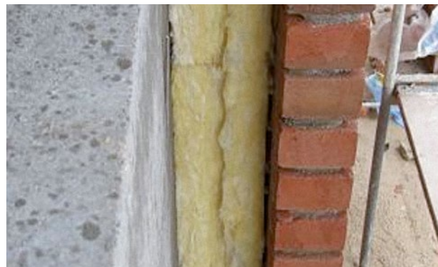
Abbildung 76 Einbau einer Kerndämmung (Neubau)
