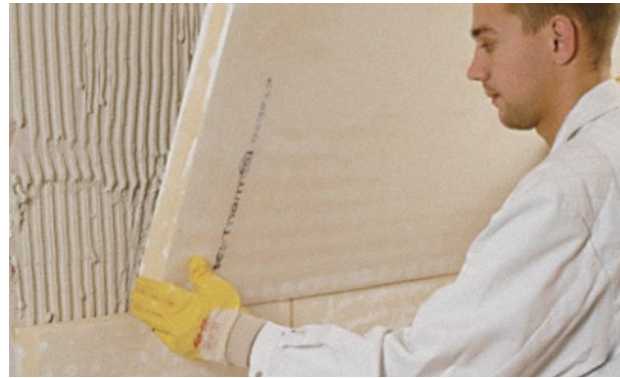
Abbildung 77/78 Vollflächiges Verkleben einer kapillaraktiven Innendämmung
