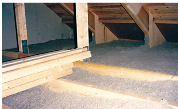
Abbildung 54 Dämmung der obersten Geschossdecke mit Zellulose-Einblasdämmung
