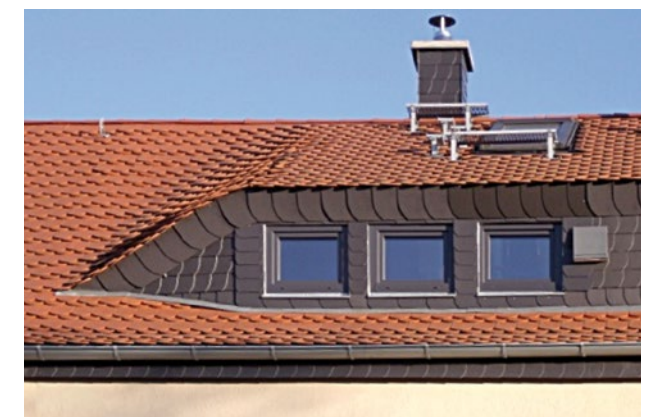
Abbildung 25 Saniertes Dach mit Dachgaube
