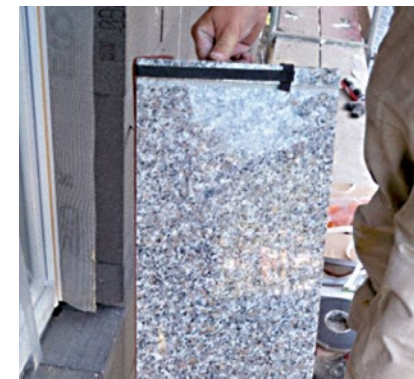
Abbildung 90/91 Fensterbank mit aufgeklebtem Quellband
