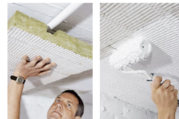
Abbildung 92/93 Anbringen einer mineralischen Unterdeckendämmung
