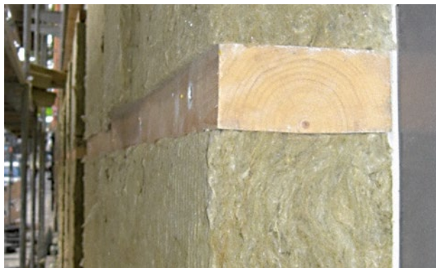
Abbildung 72 Wärmeschicht zwischen der Holzunterkonstruktion
