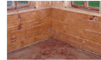
Abbildung 18 Rauminnecke einer Außenwand aus Holz-Blockbohlen
