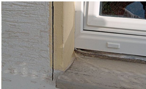
Abbildung 87 Massiver Mauerwerksanschlag wird eingeschnitten und abgebrochen
