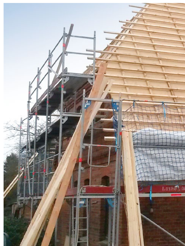
Abbildung 26 Nachträgliche Dämmung von außen mit Verlängerung des Dachüberstandes
