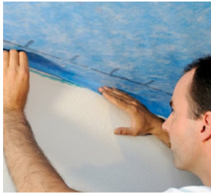
Abbildung 46 Andrücken der Dampfbremsefolie auf die Klebewulst
