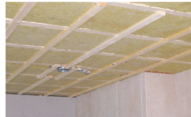
Abbildung 56 Einbau einer Unterdeckendämmung aus Mineralwolle
