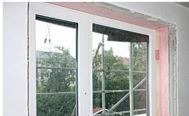
Abbildung 88 Einbau eines neuen Fensters mit Dichtklebeband
