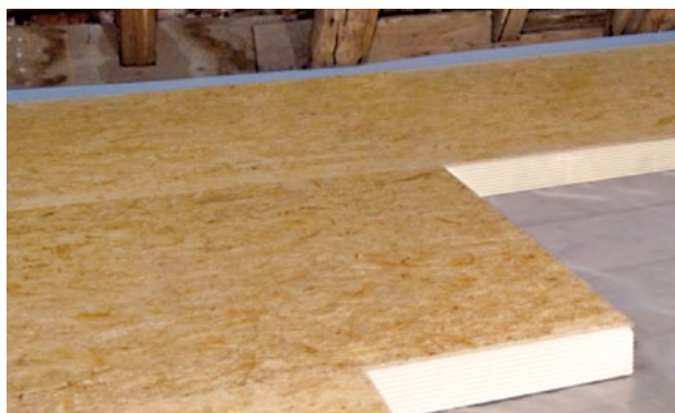
Abbildung 53 Einbau von druckfesten Hartschaumplatten mit OSB-Oberfläche
