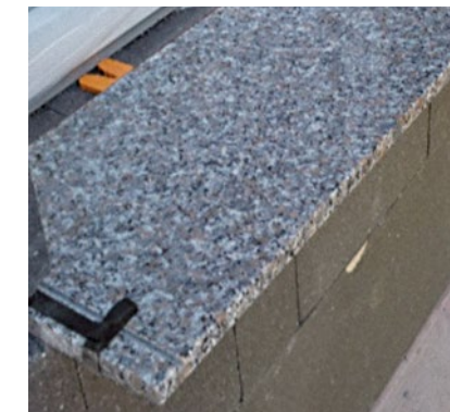
Abbildung 90/91 Fensterbank mit aufgeklebtem Quellband
