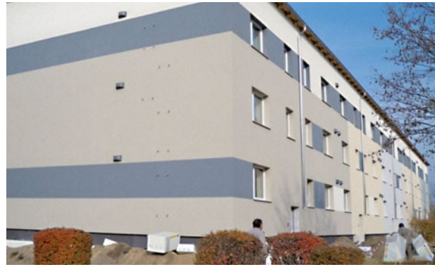
Abbildung 63/64 Anwendung einer Außendämmung bei der Komplexsanierung eines „Plattenbaus“
