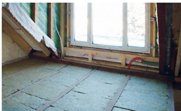
Abbildung 55 Zwischensparrendämmung mit Mineralwolle
