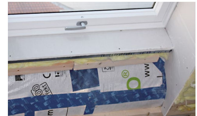
Abbildung 44 Anschluss Dampfbremse an Dachfenster
