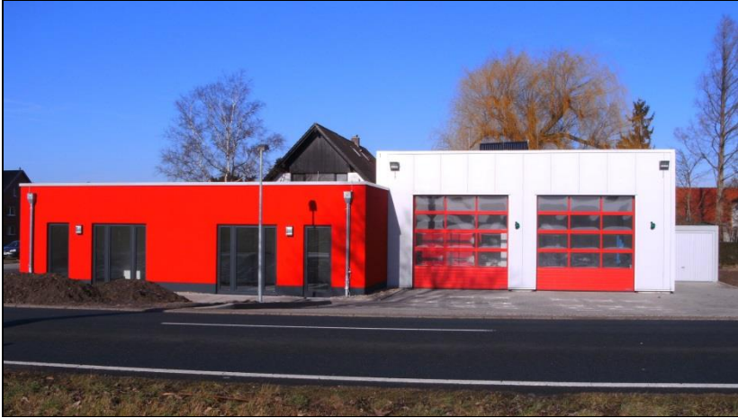
Feuerwehrhaus Müllingen - Wirringen
