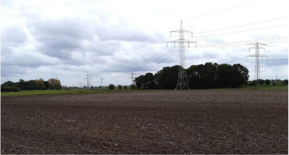
Abb. 25: Der Blick in die Landschaft von den Grünlandflächen südlich des NSG Hahnenkamps. Hierbei kommt es zu einer Bündelung mehrerer Freileitungen, die eine Beeinträchtigung für das Landschaftsbild darstellen.
